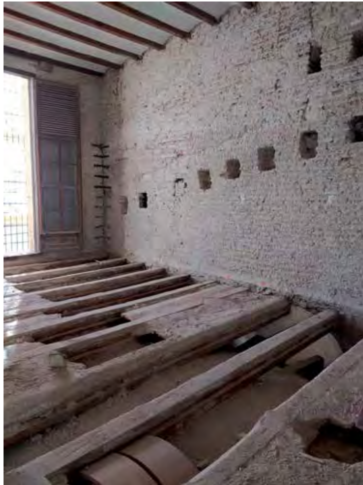
Fig. 8.- Forjado primero del espacio de la sacristía barroca. Fotografía del autor.
