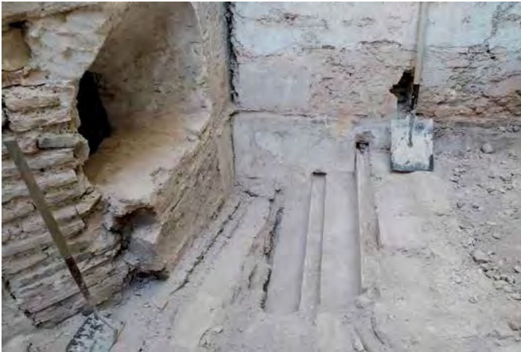
Fig. 7.- Escalera descubierta en cubierta de la sala capitular. Fotografía del autor.
